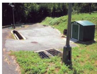
Původní čistírna odpadních vod Vojslavice
