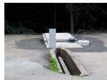
ČOV Vojslavice nově postavená
