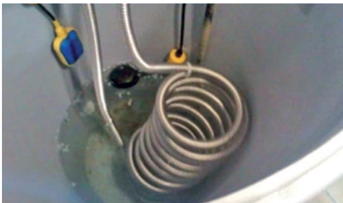
Obr. 2: Tepelný výměník v nádržích AS-GW/AQUALOOP
